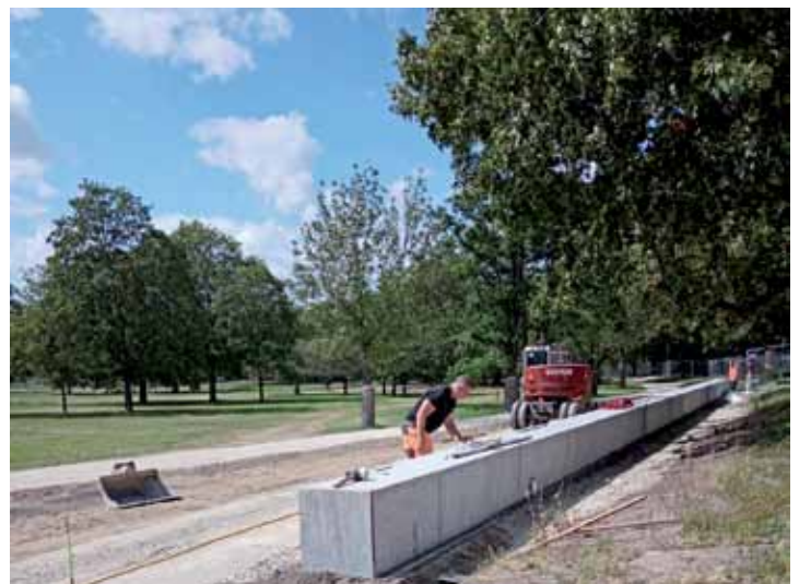
Vor dem Nordbad entsteht ein Lounge-Bereich
